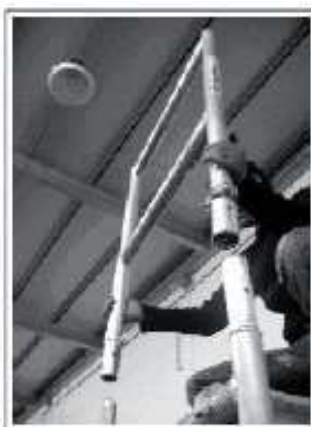
Fot.19: Montaż wieńczących ram bocznych
