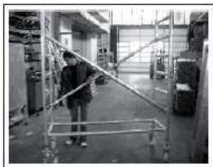
Fot.5: Montaż poprzeczek ukośnych
