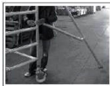
Fot.11: Montaż stabilizatora. Szczegół 2.
