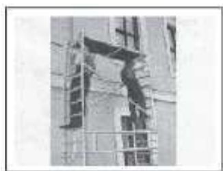
Fot.18: Montaż podestu roboczego
