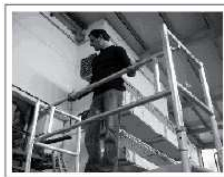
Fot.20: Montaż bocznych barierek zabezpieczających
