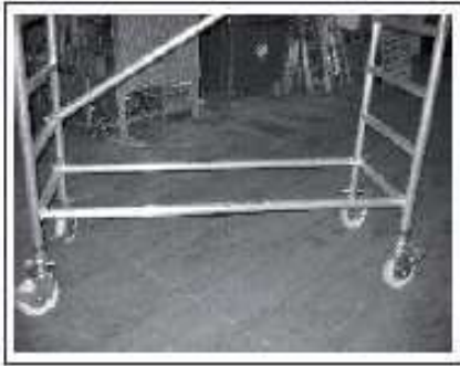
Fot.3: Montaż poprzeczek poziomych
