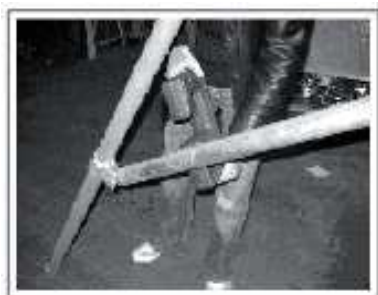
Fot.12: Montaż balastów
