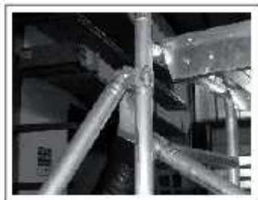
Fot.11: Montaż stabilizatora. Szczegół 1.
