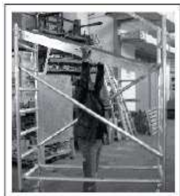
Fot.9: Montaż podestu roboczego
