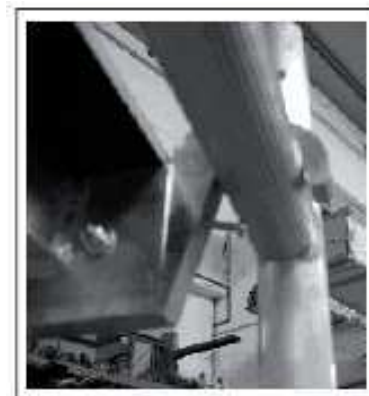
Fot.10: Blokada podestu roboczego
