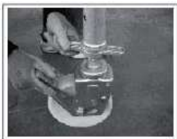
Fot.7: Wypoziomowanie rusztowania jezdnego
