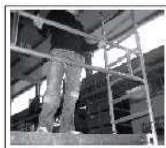
Fot.15: Montaż barierek zabezpieczających
