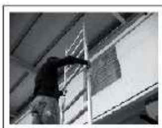
Fot.16: Montaż ram bocznych
